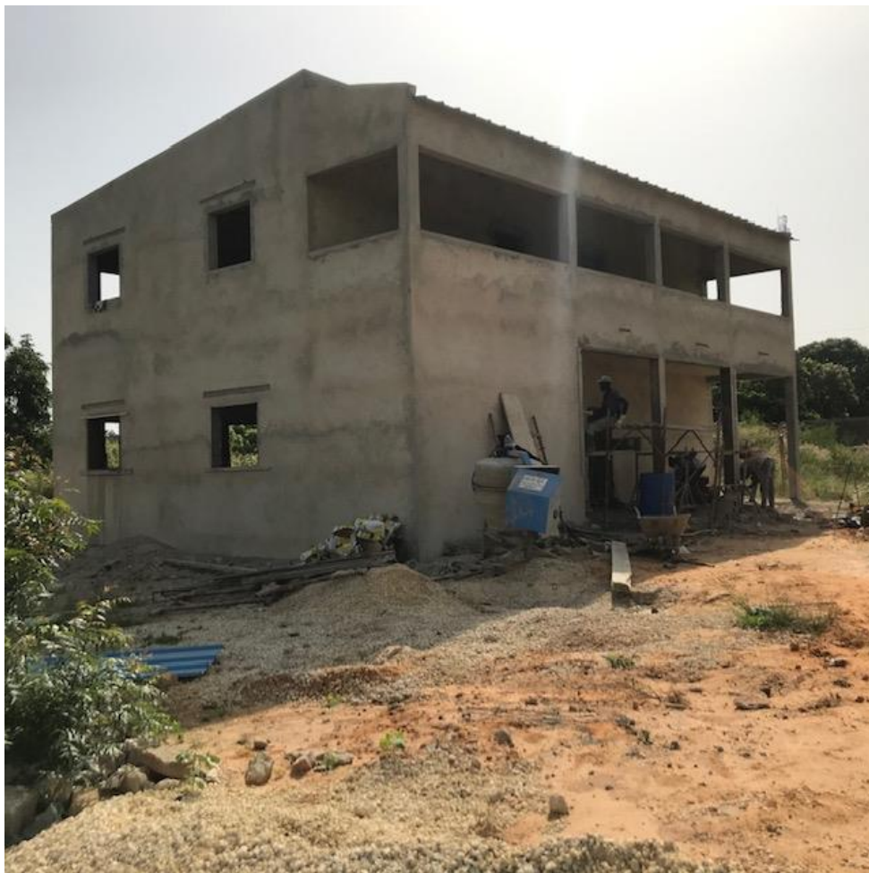
Le bâtiment 4 salles d'enseignement général en cours de construction
